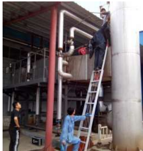
天然气锅炉排气筒
