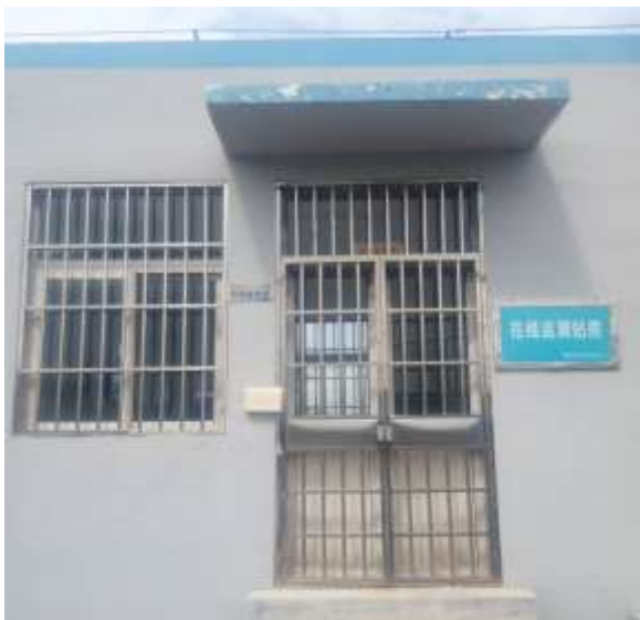
厂区污水在线检测站房
