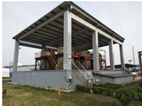
乙醇罐区围堰
