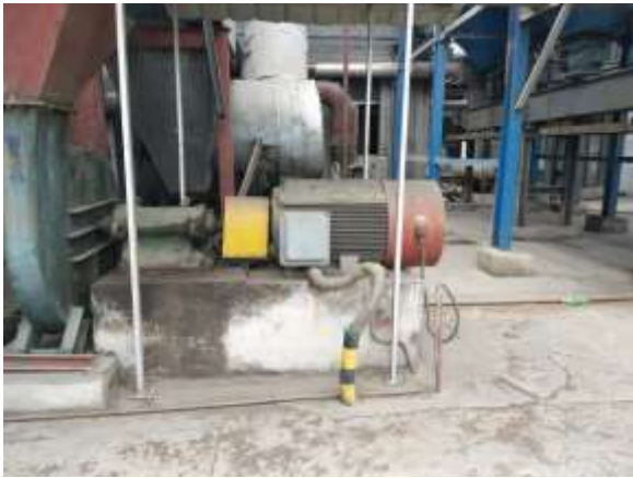
生物质锅炉风机基础减震
