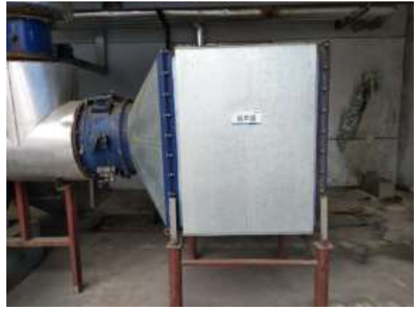
燃气锅炉消声器
