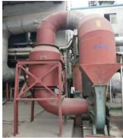
生物质锅炉风机消声器
