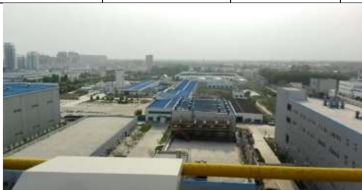
图 3-1 厂区西侧实景图
