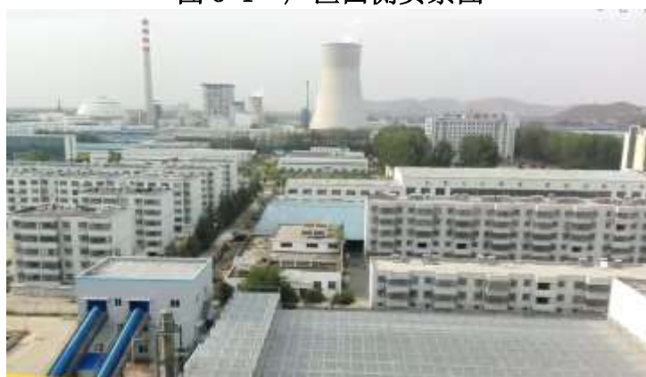
图 3-2 厂区北侧实景图
